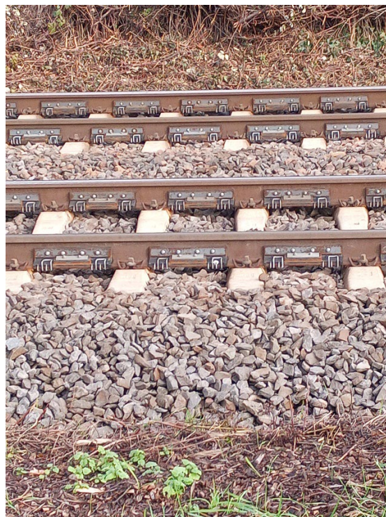
Abbildung 69: Messaufbau der Messung am 18.12.2019 (links) zur Erfassung der Lärmsanierungsmaßnahme „Schienenstegdämpfer“ (rechts)
