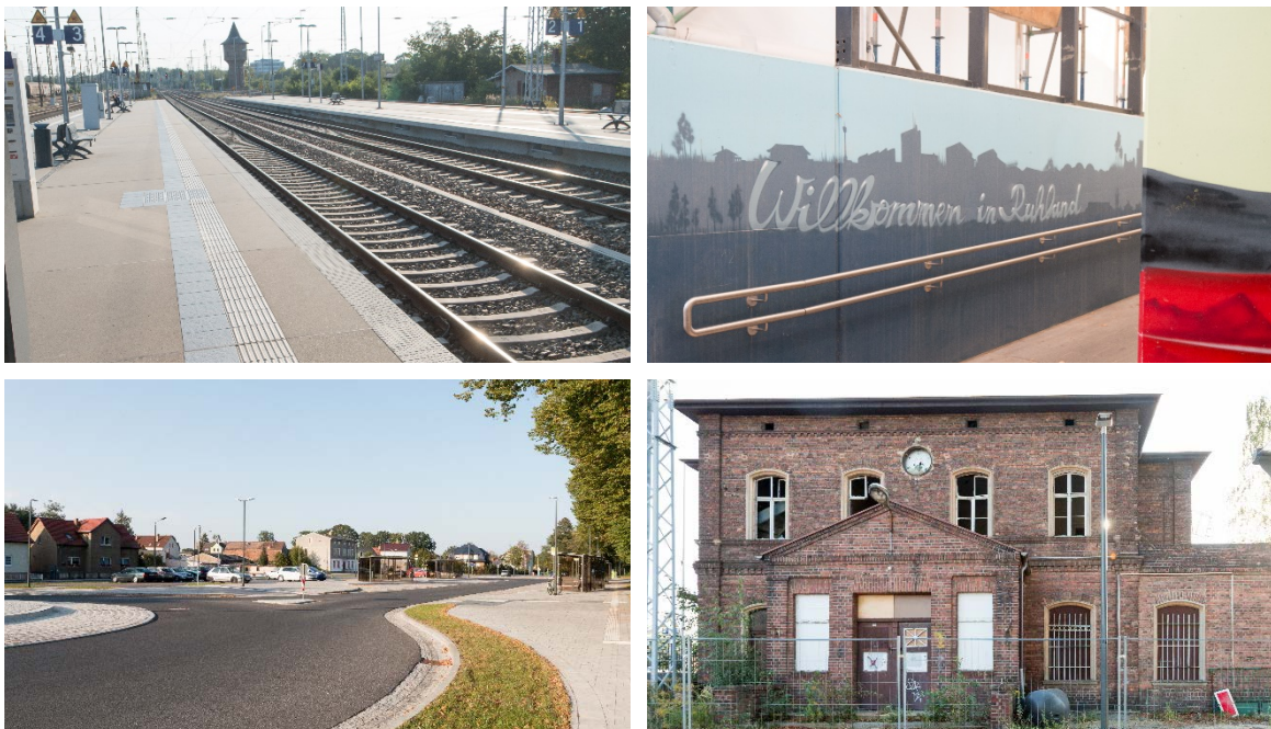
Abbildung 13.45: Neu sanierter Personenbahnhof Ruhland mit marodem Empfangsgebäude (Eigene Aufnahmen)
