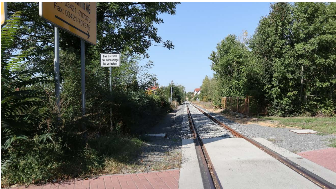
Abbildung 13.34: Anschlussgleis der SBO Torgau im Bereich der Naundorfer Str. (Eigene Aufnahmen)
