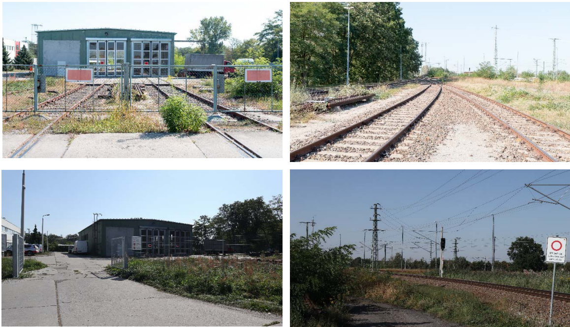
Abbildung 13.38: Verbindungskurve in Falkenberg im Bereich der Schützenstr. 21 (Eigene Aufnahmen)
