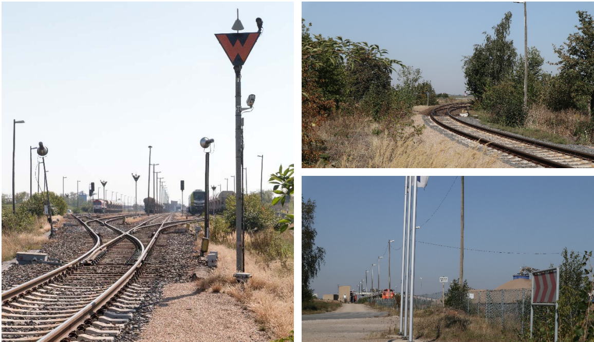
Abbildung 13.35: Gleisanschluss und Betriebsgelände des Kieswerks Mühlberg (Eigene Aufnahmen)
