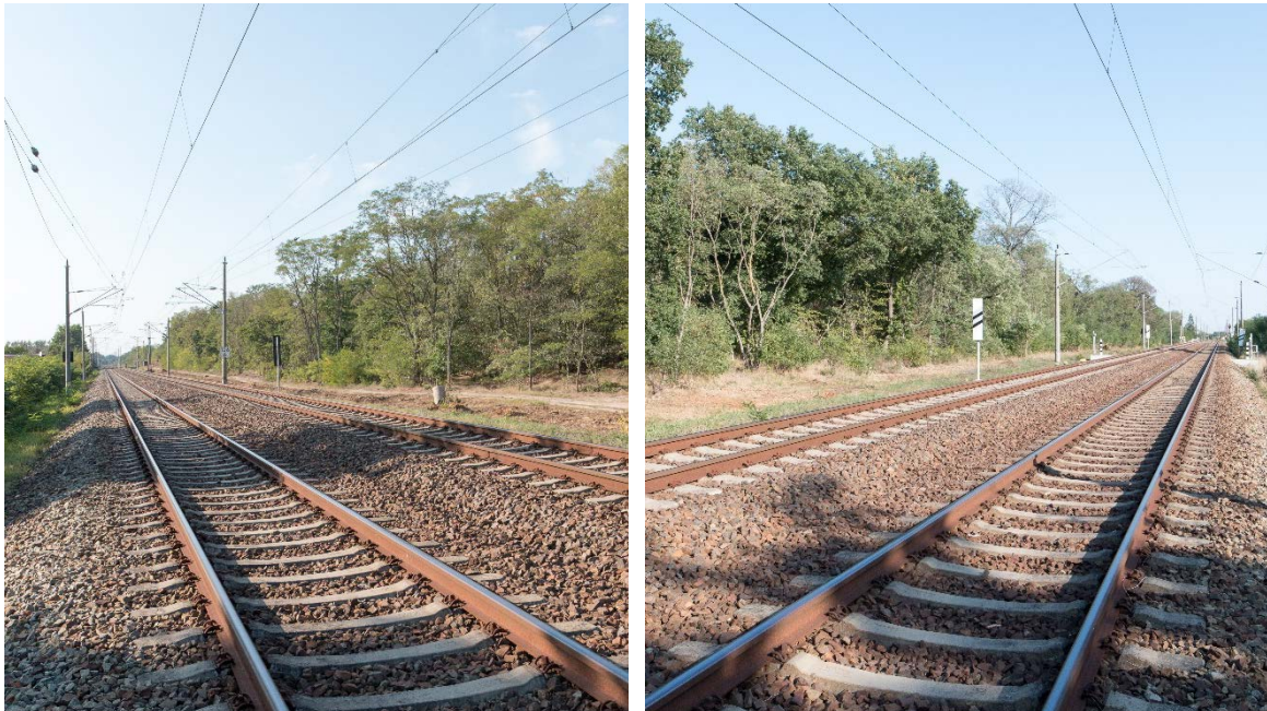
Abbildung 13.44: Streckengleise der Strecke 6207 in Biehla im Bereich der Straße Am Stein (Eigene Aufnahmen)
