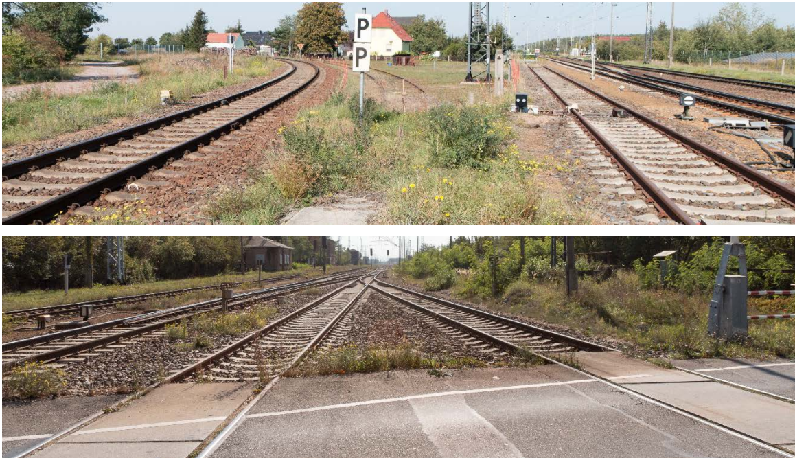
Abbildung 13.37: Blick vom BÜ auf die Strecken 6827 und 6133 in nördlicher und südlicher Richtung (unten) (Eigene Aufnahmen)
