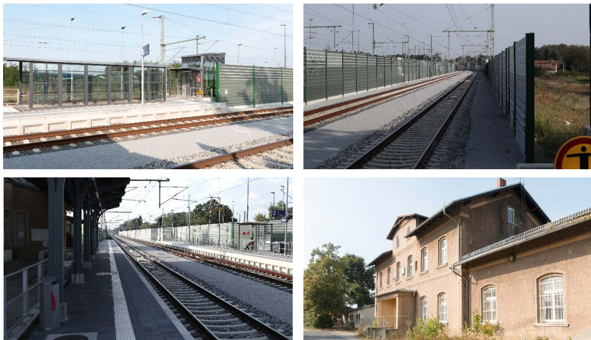
Abbildung 13.57: Neu sanierter Personenverkehrsteil des Bahnhofs Niesky mit marodem Empfangsgebäude (Eigene Aufnahmen)
