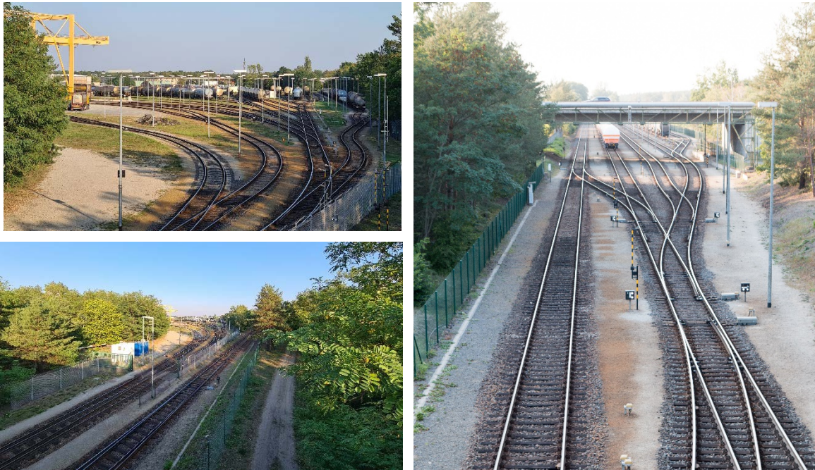
Abbildung 13.47: Anschluss der BASF Schwarzheide GmbH von der Brücke Schipkauer Str. aufgenommen (Eigene Aufnahmen)
