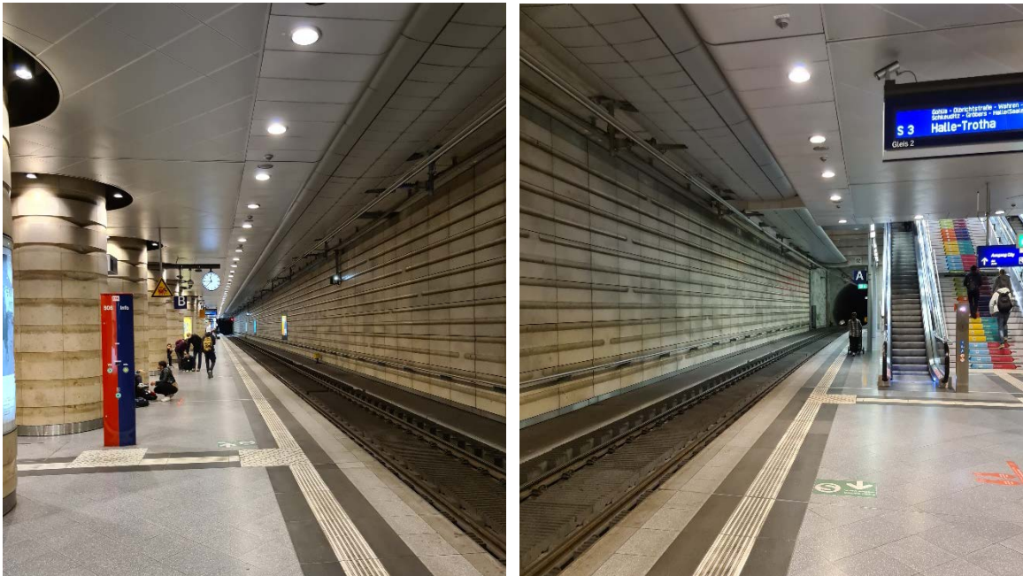
Abbildung 13.62: Citytunnel Leipzig Gleis 2 (Eigene Aufnahmen)
