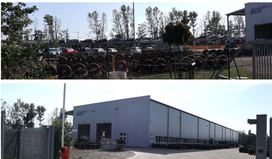
Abbildung 13.43: Werkstätte der BLG RailTec und zugehörige hoch ausgelastete Gleisgruppe (Eigene Aufnahmen)
