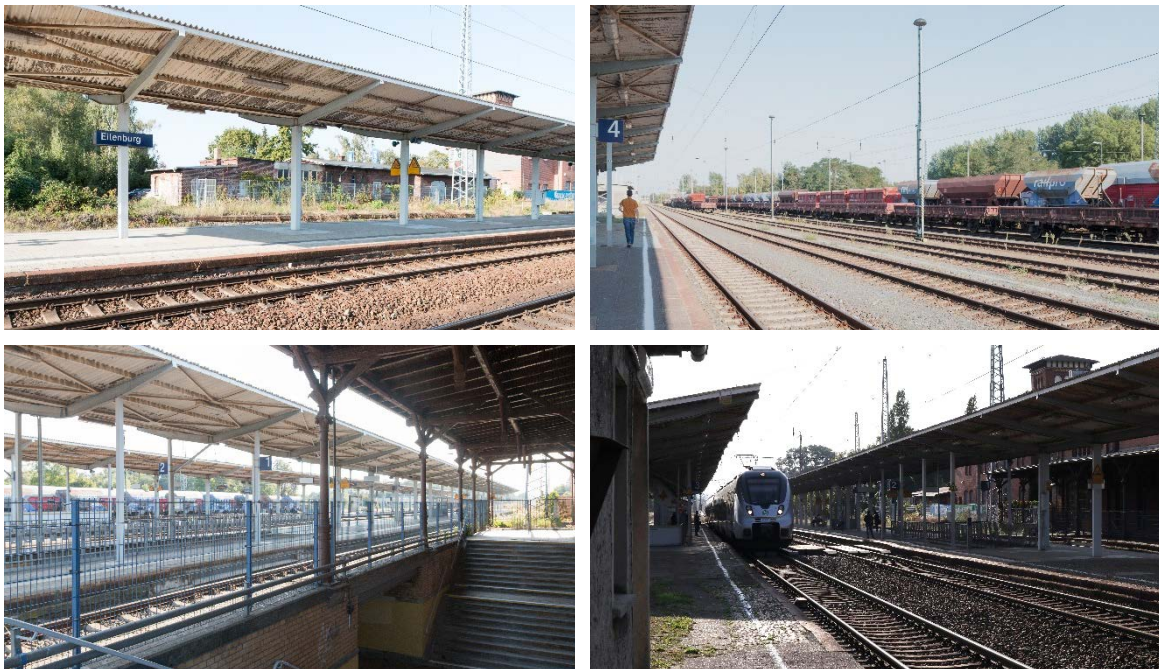
Abbildung 13.25: Personenverkehrsteil des Bahnhofs Eilenburg (Eigene Aufnahmen)
