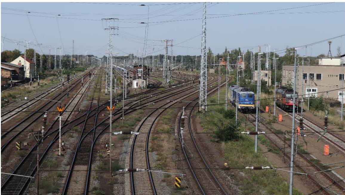
Abbildung 13.40: Blick von Brücke der Uebigauer Str. in nördliche Richtung (Eigene Aufnahme)
