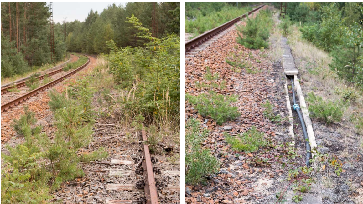
Abbildung 13.61: Zweigleisige nicht mehr genutzte Kohlebahn mit Kabelschacht im Bereich Boxberg (Eigene Aufnahmen)
