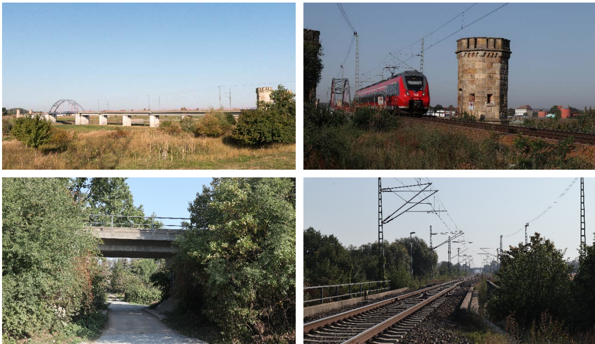
Abbildung 13.31: Einleisiger Abschnitt der Strecke 6345 im Bereich der Elbbrücke (Eigene Aufnahmen)
