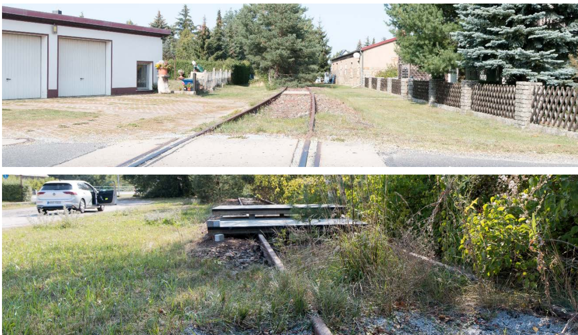
Abbildung 13.54: Nicht mehr in Betrieb befindliche Strecke 6577 in Lodenau in nördlich und südliche Richtung (unten) (Eigene Aufnahmen)
