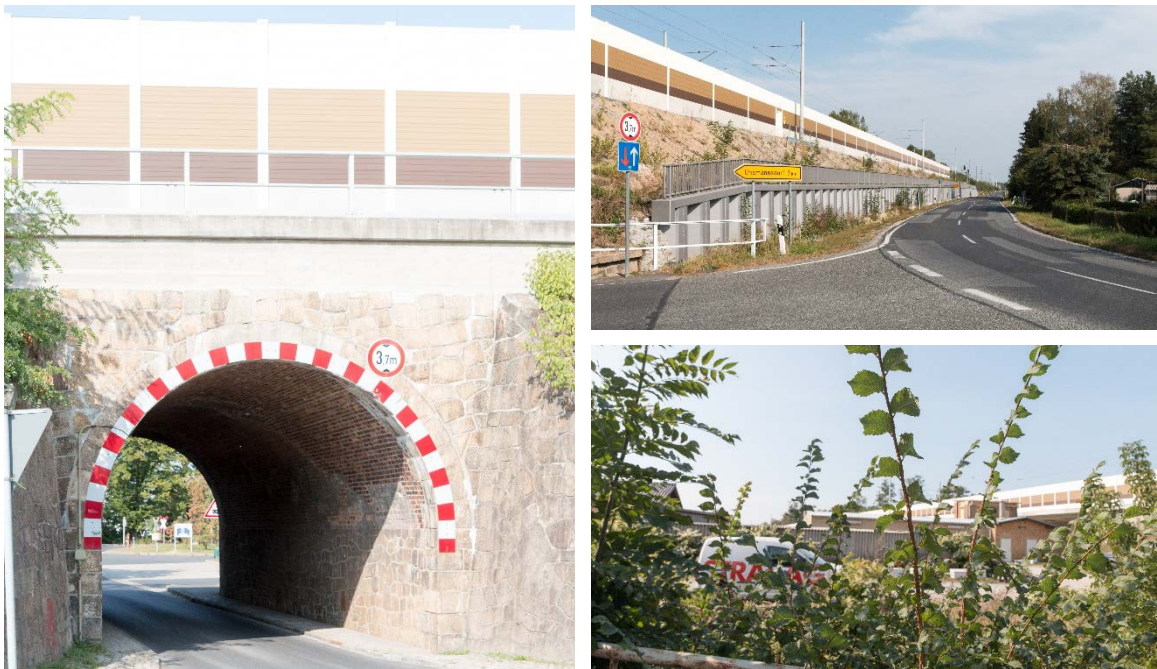
Abbildung 13.56: Lärmschutz in Horka im Bereich der Rothenburger Straße/Uhlmannsdorfer Str. (Eigene Aufnahmen)
