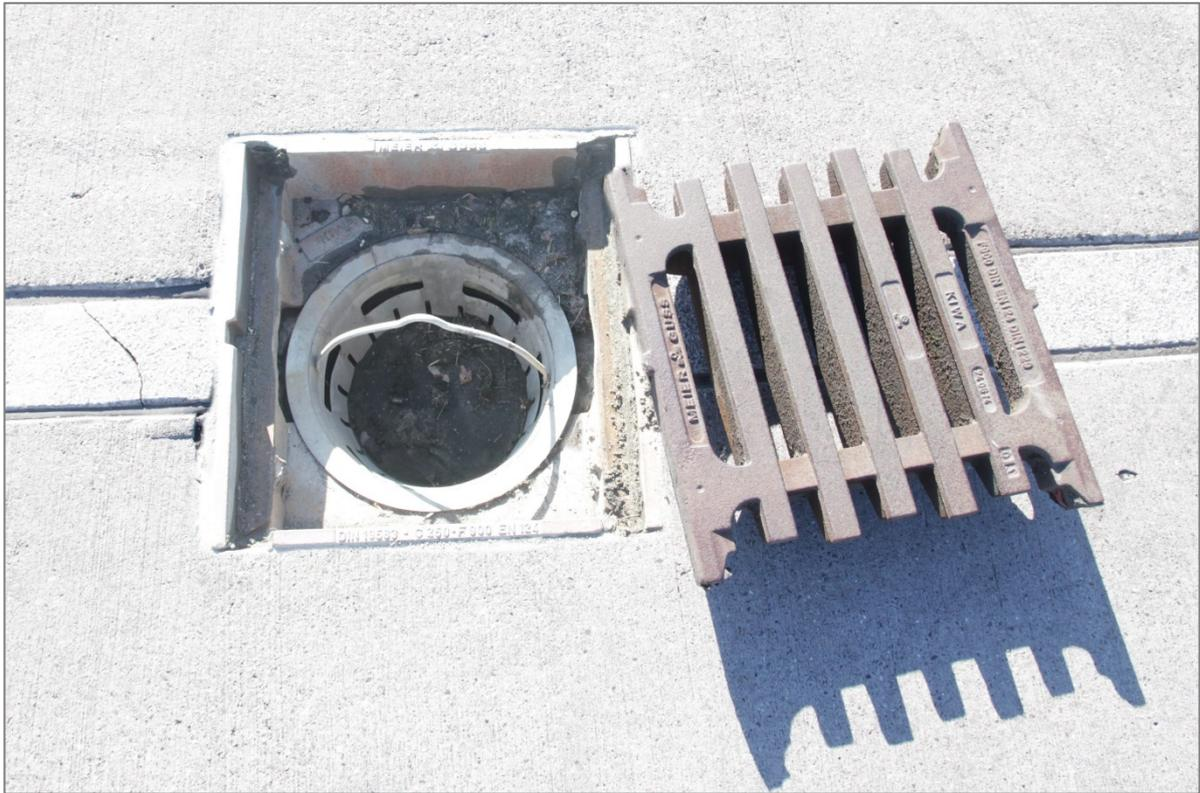
Abbildung 11: Schlammeimer eines Straßenoberflächenablaufes auf dem LKW-Parkplatz am Kombiterminal des unbegleiteten Verkehrs in Singen.
