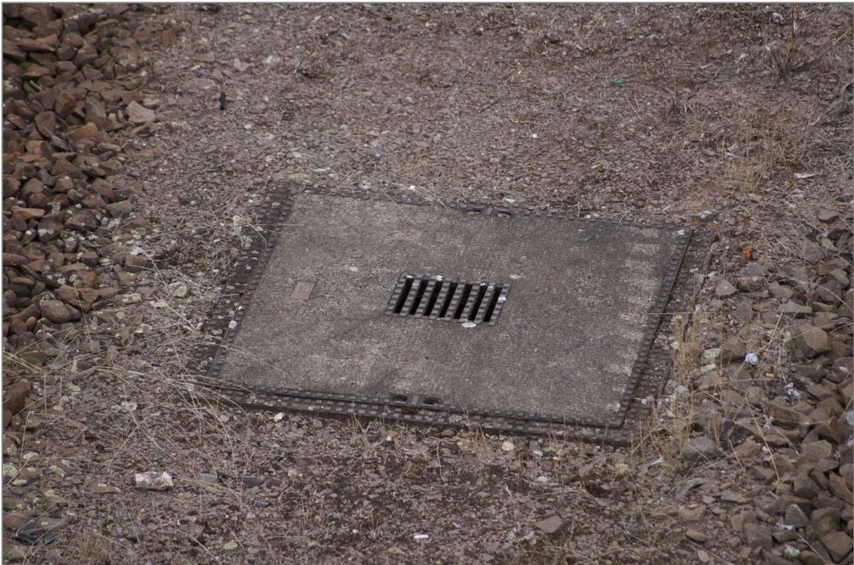
Abbildung 13: Beton-Kabelschachtdeckel mit Lüftungsgitter am Bahnhof Schifferstadt.
