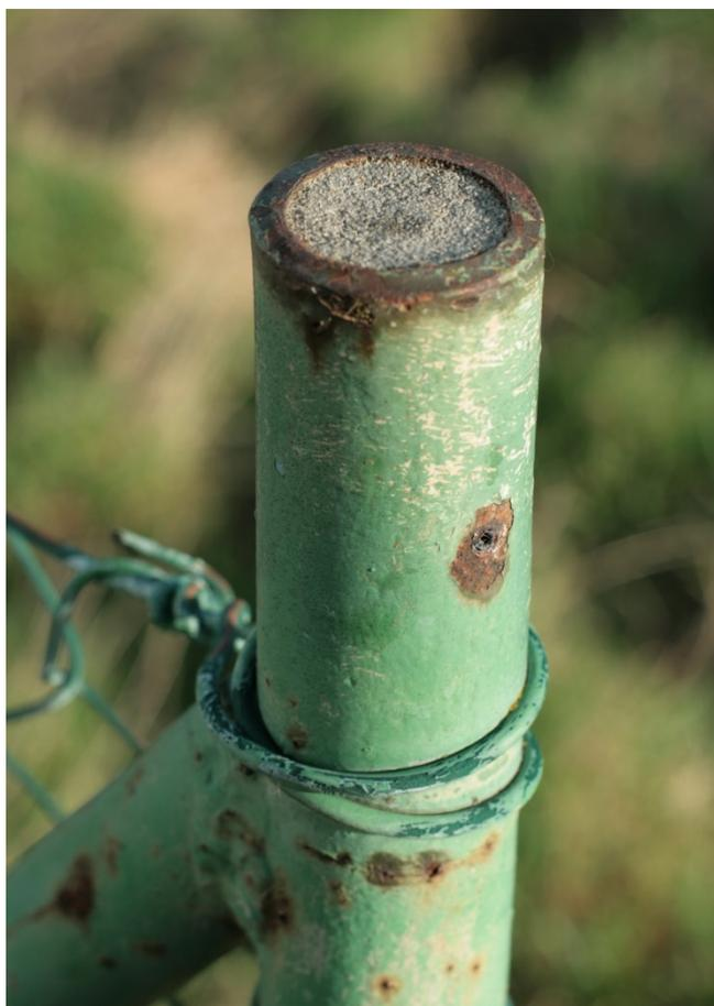
Abbildung 46: Mit Zement verschlossener Zaunpfahl.
