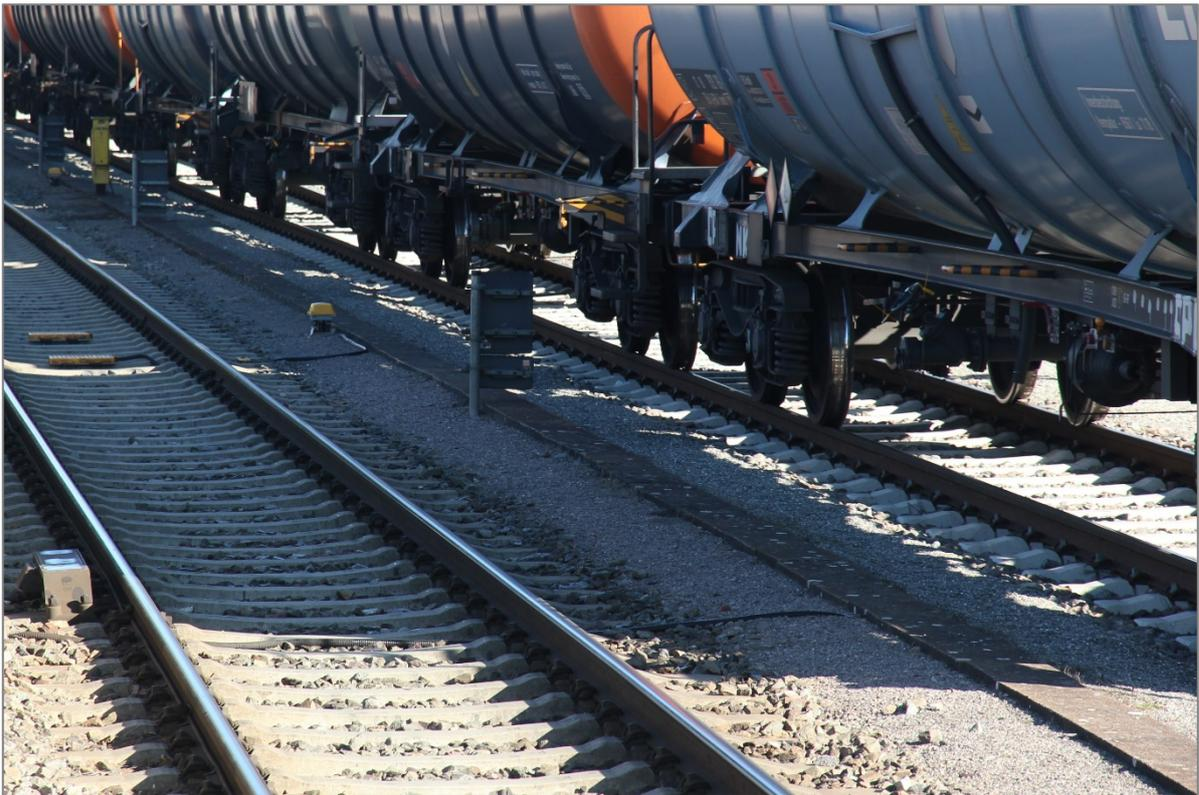
Abbildung 29: Kabelkanal zwischen den Gleisen am Hauptbahnhof Singen
