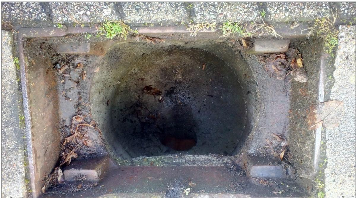
Abbildung 12: Nach Entfernung des Einlaufgitters und des Schlammeimers sichtbarer direkter Wasserablauf eines Oberflächenablaufes am Bahnhof Germersheim.
