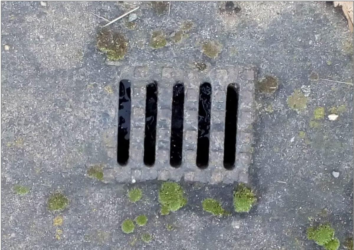
Abbildung 14: Durch das Lüftungsgitter eines Kabelschachtdeckels sichtbare Wasseransammlung am Betriebsbahnanlage Mannheim-Rheinau.
