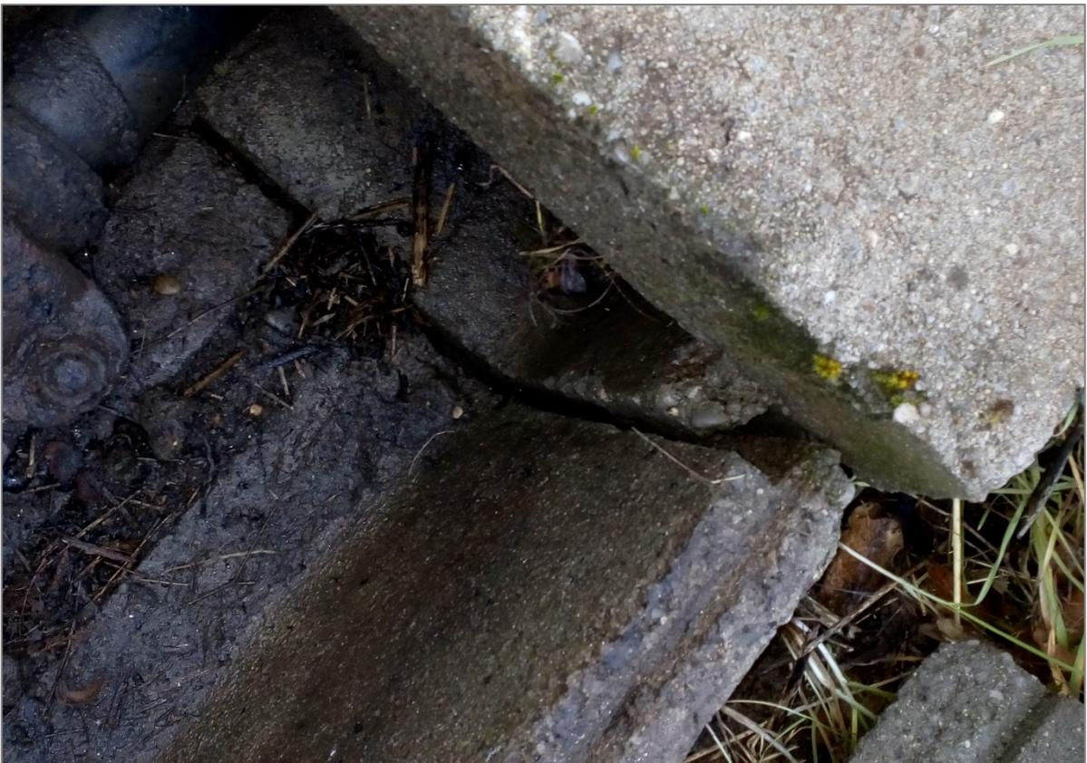
Abbildung 30: Stoßfuge zwischen zwei Bauteilen eines Kabelkanals am Kombiterminal des begleiteten Verkehrs in Freiburg.
