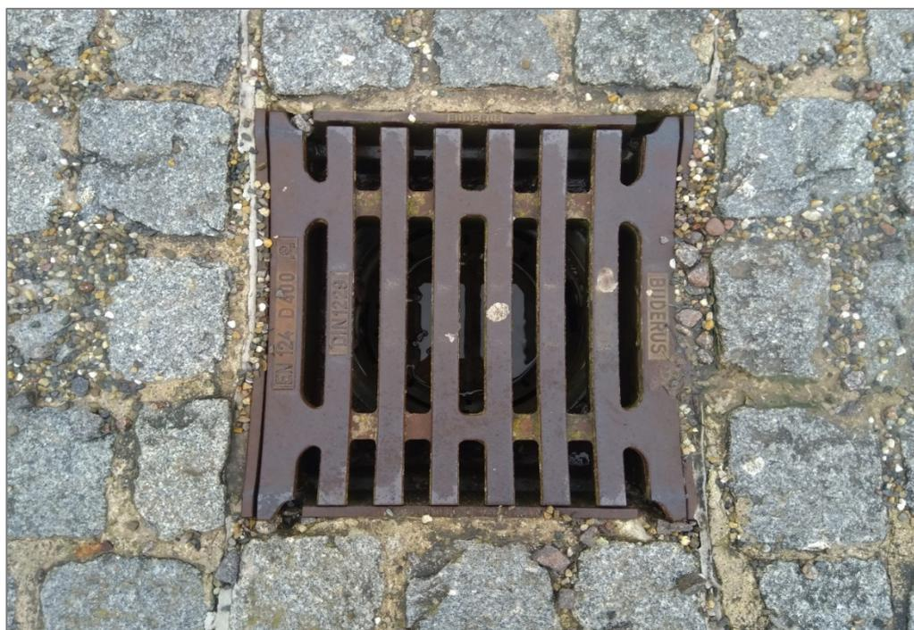
Abbildung 10: Durch das Einlaufgitter sichtbare Wasseransammlung in einem Schlammeimer eines Straßenoberflächenablaufes auf der LKW-Zufahrt am Kombiterminal des begleiteten Verkehrs in Freiburg.
