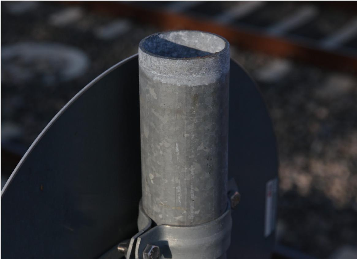
Abbildung 5: Schildmast ohne Rohrkappe am Bahnhof Wiesloch-Walldorf
