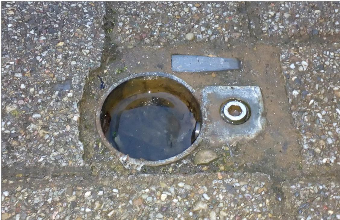
Abbildung 7: Freie Bodenhülse eines Absperrpfostens am Bahnhof Speyer
