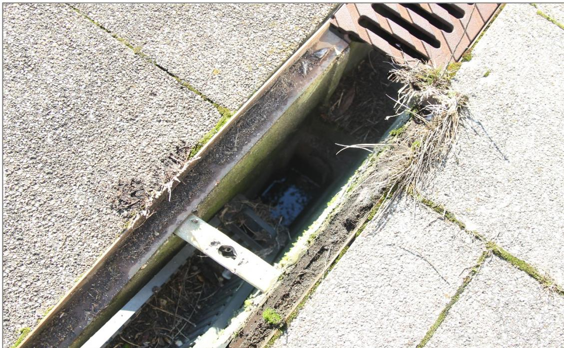
Abbildung 9: Senkkasten einer Entwässerungsrinne mit Wasseransammlungen unter dem Schmutzsieb am Hauptbahnhof Singen
