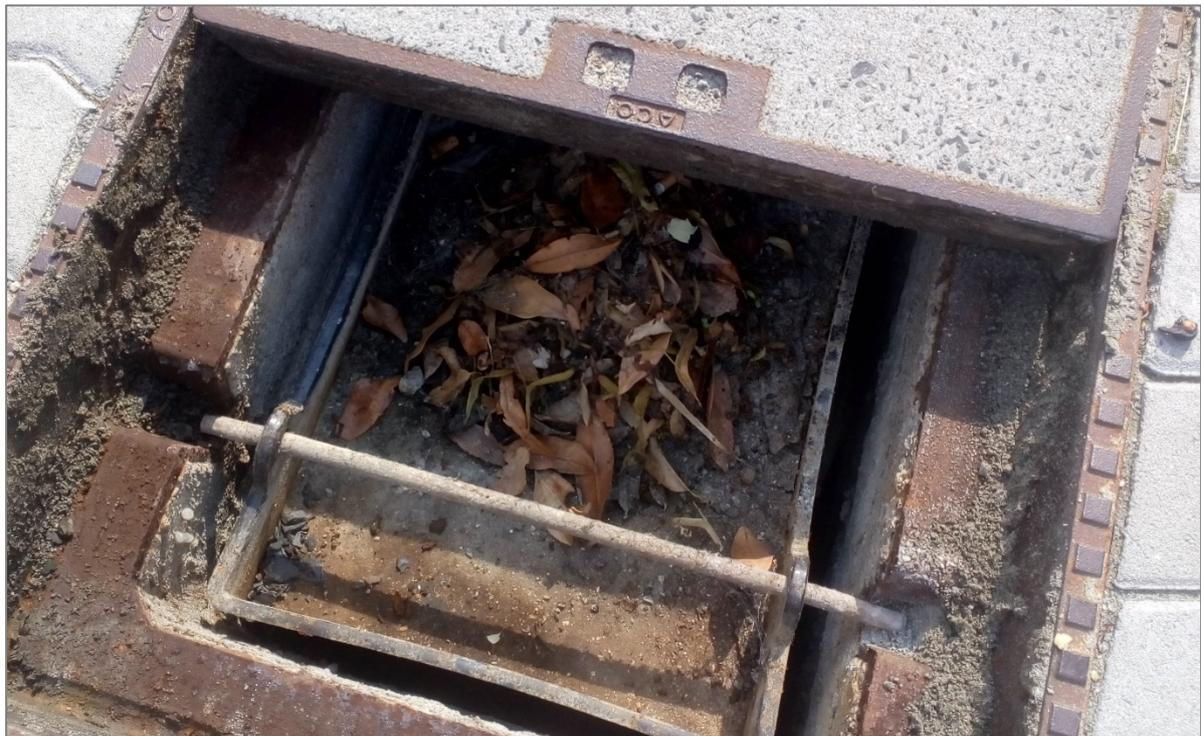
Abbildung 15: Schmutzfangschale im oberen Bereich eines Kabelschachtes
