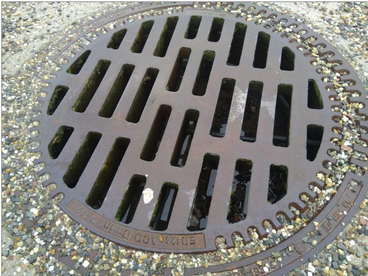
Abbildung 17: Durch das Lüftungsgitter eines Revisionsschachtes sichtbare Wasseransammlung am Kombiterminal des begleiteten Verkehrs in Freiburg.
