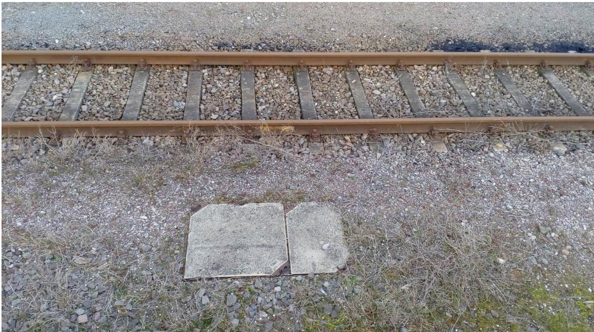
Abbildung 47: Kabelschacht mit tagwasserdichtem Deckel am Wartegleis Schwetzingen.
