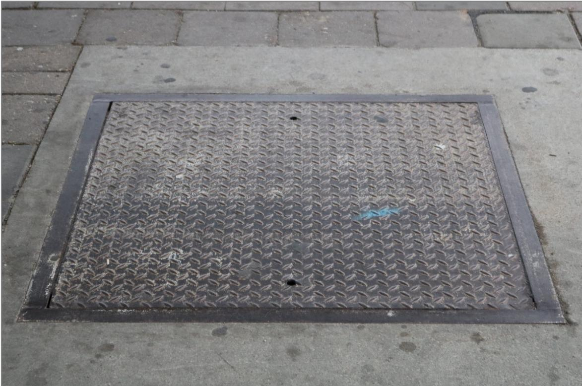
Abbildung 16: Metall-Schachtdeckel mit kleinen Öffnungen für Hebelwerkzeuge am Bahnhof Königs-Wusterhausen.
