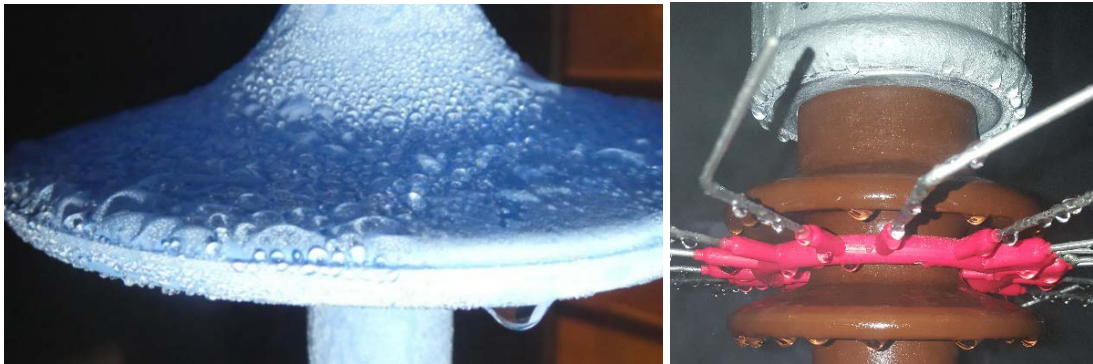
Abbildung 18: Niederschlag nach 2 h Benebelung. Am Verbundisolator bilden sich aufgrund dessen Hydrophobie vereinzelte Tröpfchen aus
