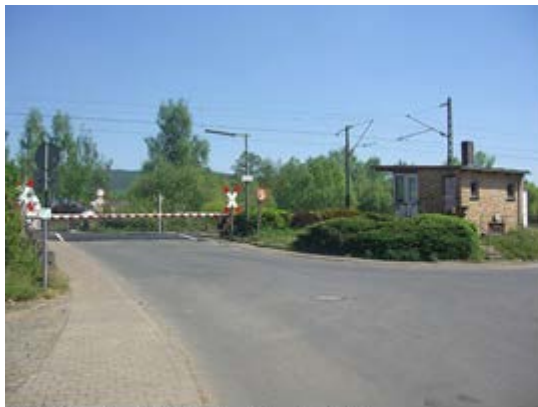
Wärterbediente Schranken (Quelle: Mini-BahnschrankeHauneckUnterhaun.jpg, © Flash112 auf Wikimedia Commons und Wikipedia-DE, Lizenz: CC BY-SA 2.0 DE)
