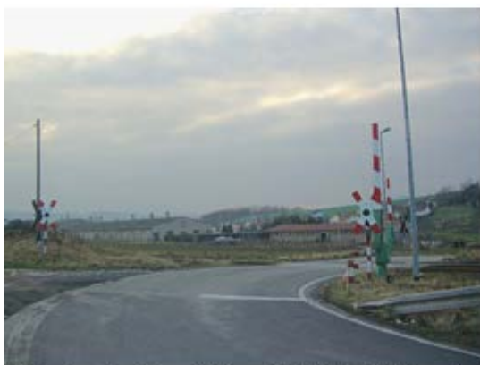
Halbschranken (BueexDDR.jpg, © Flash112 auf Wikimedia Commons und Wikipedia-DE, Lizenz: CC BY-SA 2.0 DE)
