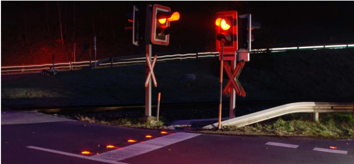
Abbildung 40: Fahrbahnlichter vor dem BÜ [37]
