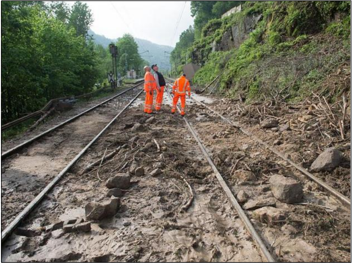
Abbildung 1: Massenauftrag durch einen Schuttstrom entlang der Bahnlinie Bad-Schandau – Schöna am 24.05.2016 (Bildquelle: dpa/Sebastian Kahnert)
