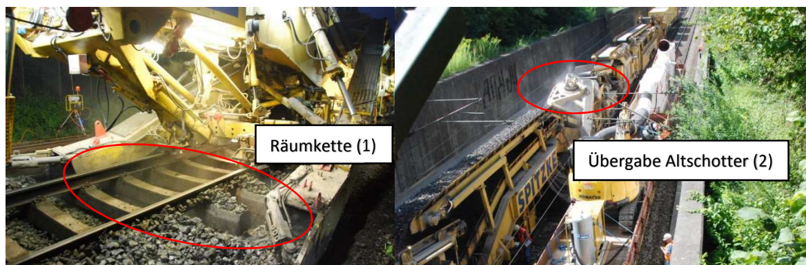
Abbildung 5.2: Aushubbereich der Räumkette & Übergabe Altschotter
