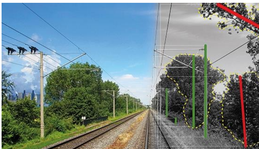
Abbildung 14: Beispieldarstellung von Veränderungen entlang einer Bahntrasse im Projekt „Zustandsüberwachung des Gleisumfeldes“ (ZuG) (Universität Stuttgart / Timo Strobel [53])
