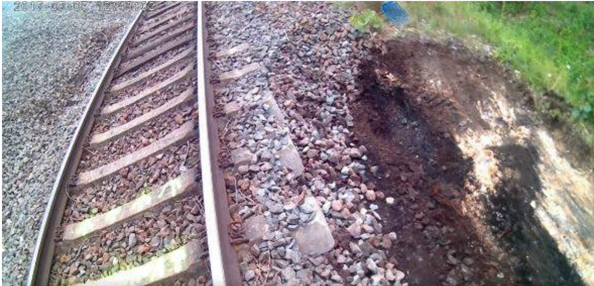
Abbildung 1: Ansicht vom Zwei-Wege-Bagger während der Schotterabtragung bahnlinks, Strecken-km 74,5. Das verzerrte Bild ergibt sich aus dem Zusammenspiel von Weitwinkel und seitlicher Anbringung der Kamera.
