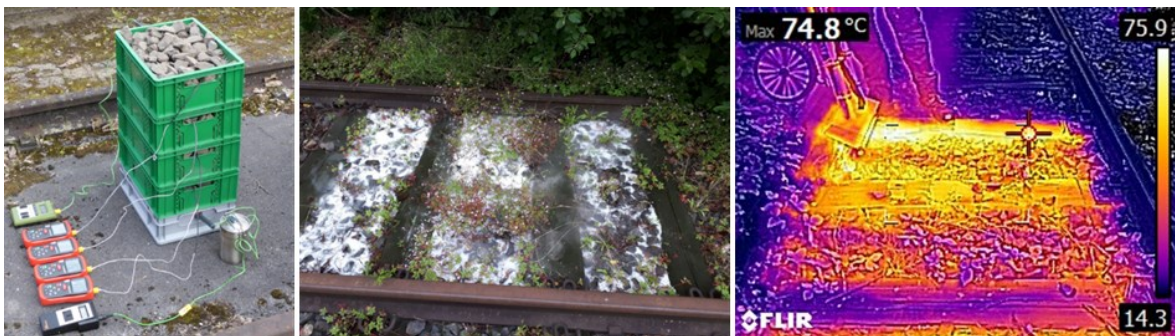
Abbildung 7: Versuchsdarstellung zur Temperaturmessung in verschiedenen Schottertiefen (links), Gleisversuch zu den Verfahren Frosten (Mitte) sowie Heißwasser (rechts); Quelle: RWTH Aachen University.
