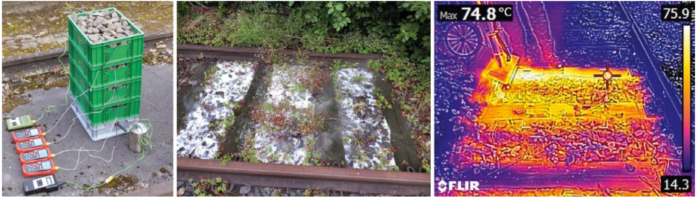
2: Versuchsdarstellung zur Temperaturmessung in verschiedenen Schottertiefen (links), Gleisversuch zu den Verfahren Frost (Mitte) sowie Heißwasser (rechts) Quelle: RWTH Aachen University; DZSF-Projekt „Entwicklung eines Alternativverfahrens zur Vegetationskontrolle auf Gleisanlagen“ [17, 18]
