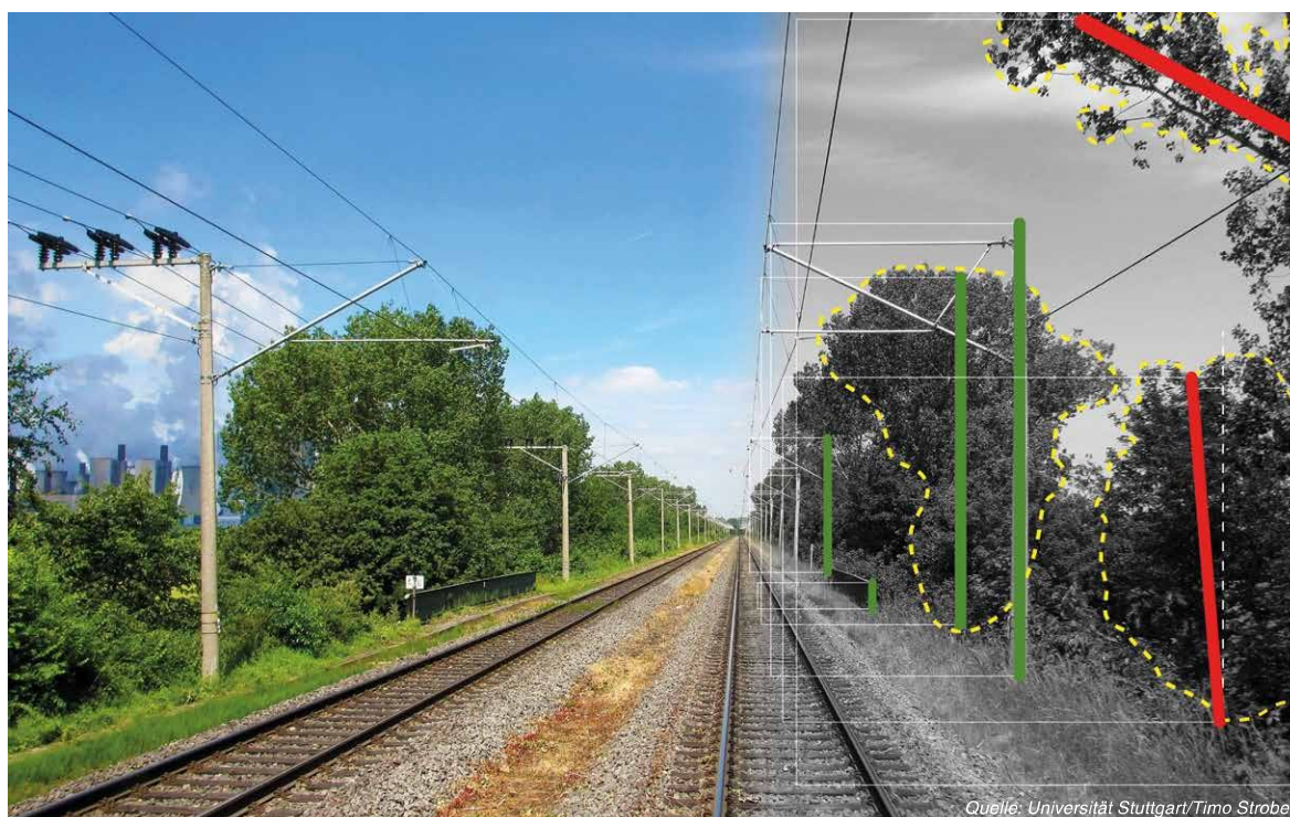
Abbildung 1: Die Digitale Streckenbeobachtung mittels aufbereiteter Videodaten ermöglicht das Erkennen und Dokumentieren von Veränderungen im Gleisumfeld
